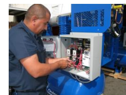
Mantenimiento y Reparaciones
